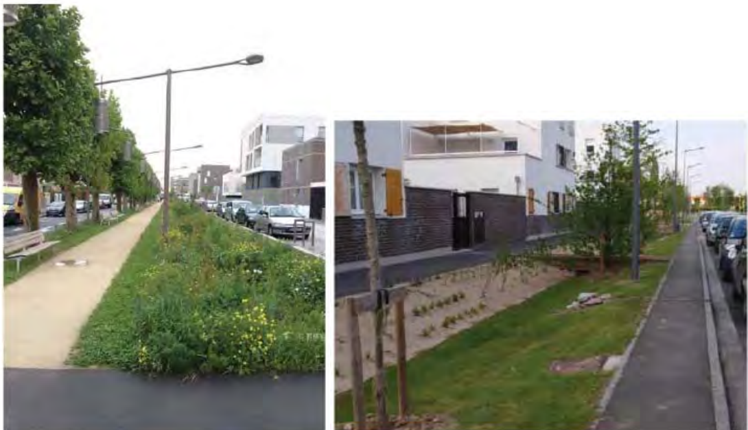
Fig. 72. Schéma et figures illustrant le futur ouvrage le long de la rue d'Albrecht. Source : MAGEO
