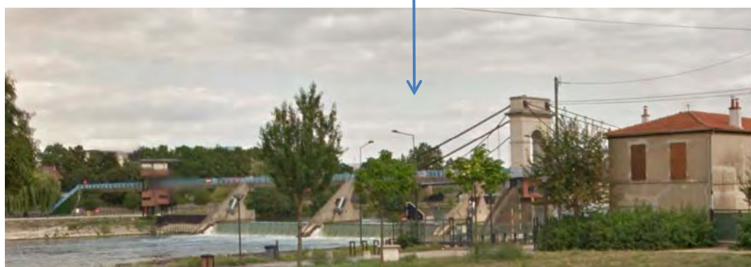
Fig. 23. Ecluses et barrage du Port à L'Anglais. Source : Google Street
